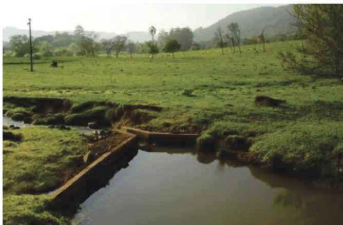
Figura 31. Riacho sem matas ciliares e com erosão de margens, com necessidade de reforço nas guias correntes da calha Fonte: Programa Estadual- RS
