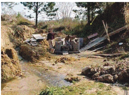
Figura 27. construção do Medidor de Vazão. Foto: Geraldo da Silveira
