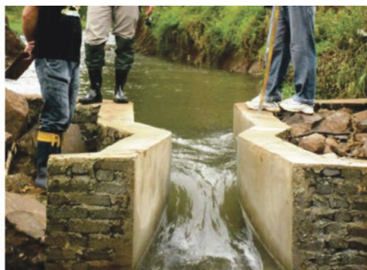
Figura 30. Calha Parshall modificada Fonte: Programa Estadual-RS
