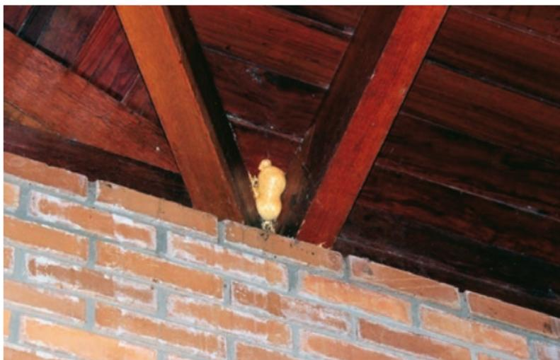
Figura 51. Espuma expansível utilizada em fresta no forro a vista.
