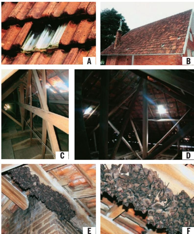
Figura 47. A-D. Telhas de vidro instaladas em diferentes telhados. E-F. Colônias de morcegos insetívoros observadas em forros com telhas de vidro.
