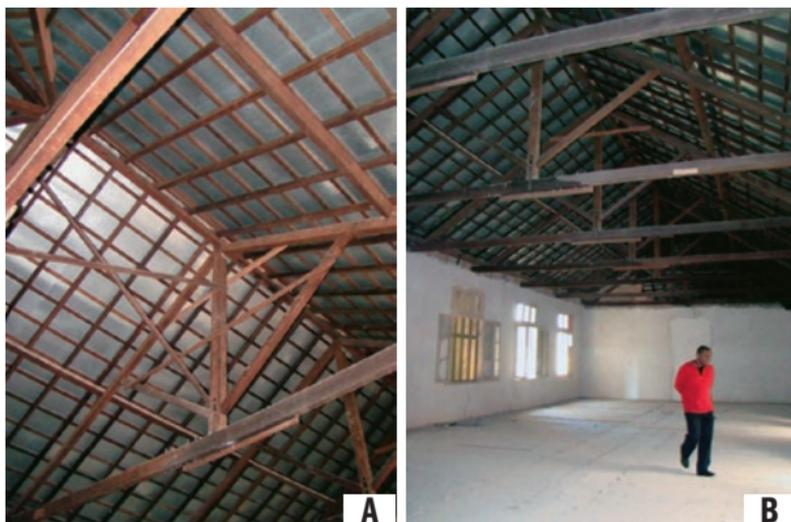
Figura 54. A, B - Placas galvanizadas instaladas abaixo do telhado.
