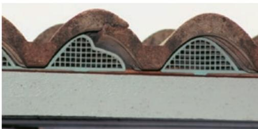
Figura 44. “Passarinheiras” instaladas junto a frente do telhado.
