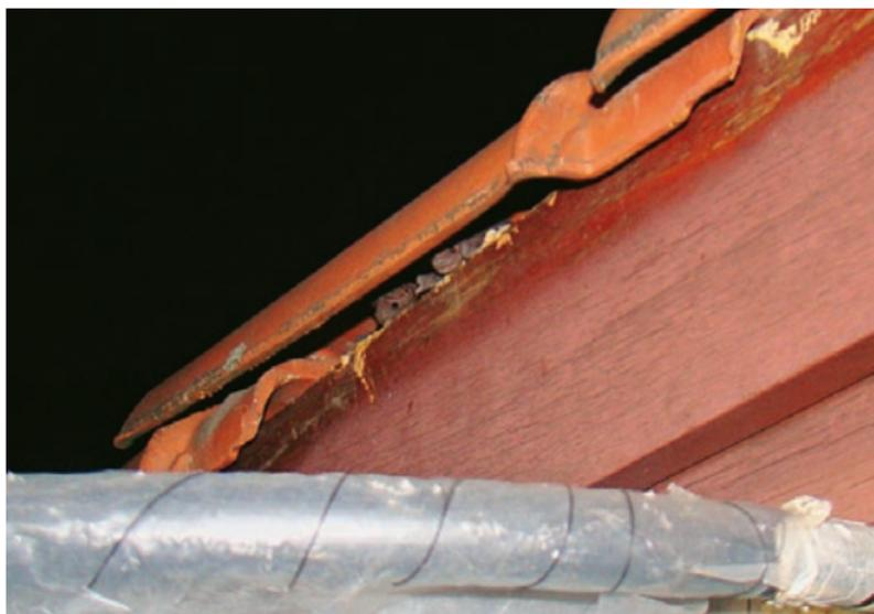
Figura 52. Espaço utilizado pelos morcegos para saída dos telhados.
