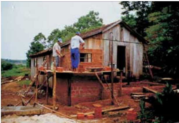
Figura 7 - Restauração de residência beneficiada pelo PMHCh em Alegria, RS, 2002.
