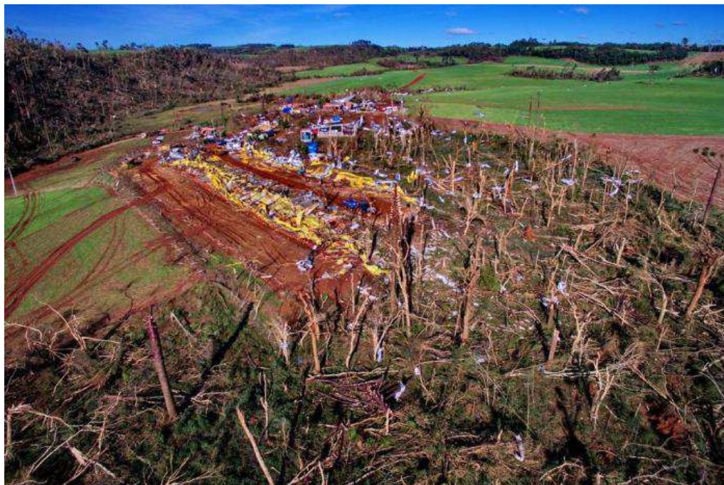
Figura 6 – Rastro de destruição deixado por provável tornado em Coxilha. (Alves, 2018)
