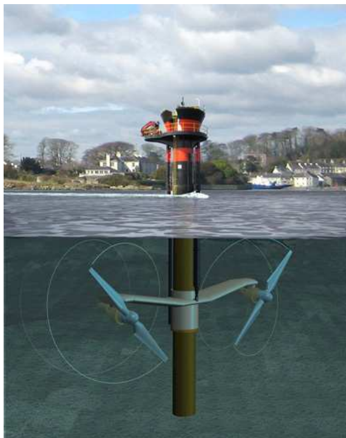
Turbina subaquática de energia das correntes das marés
