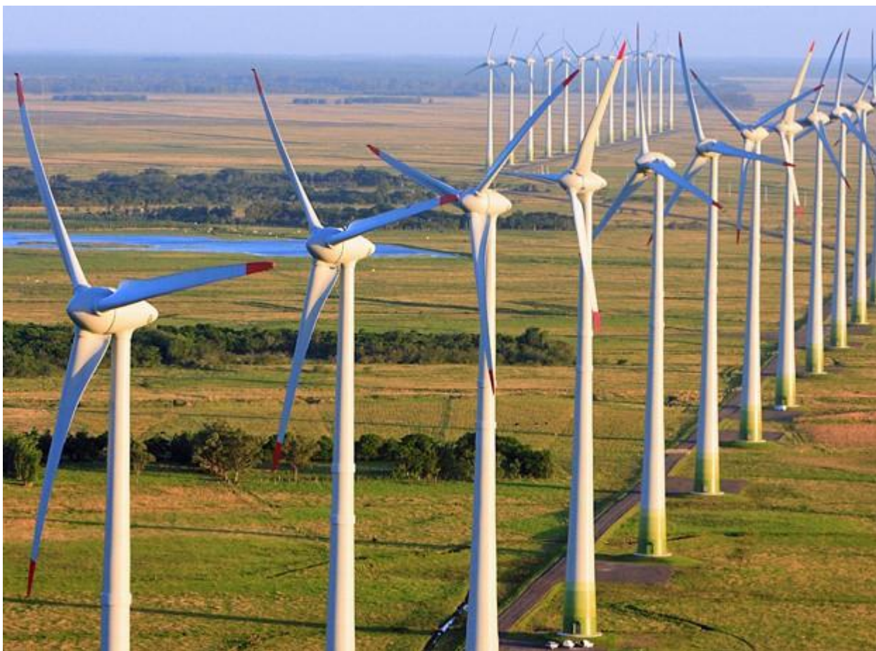
Usinas eólicas instaladas no Rio Grande do Sul (Foto: Divulgação/ABEEólica)
