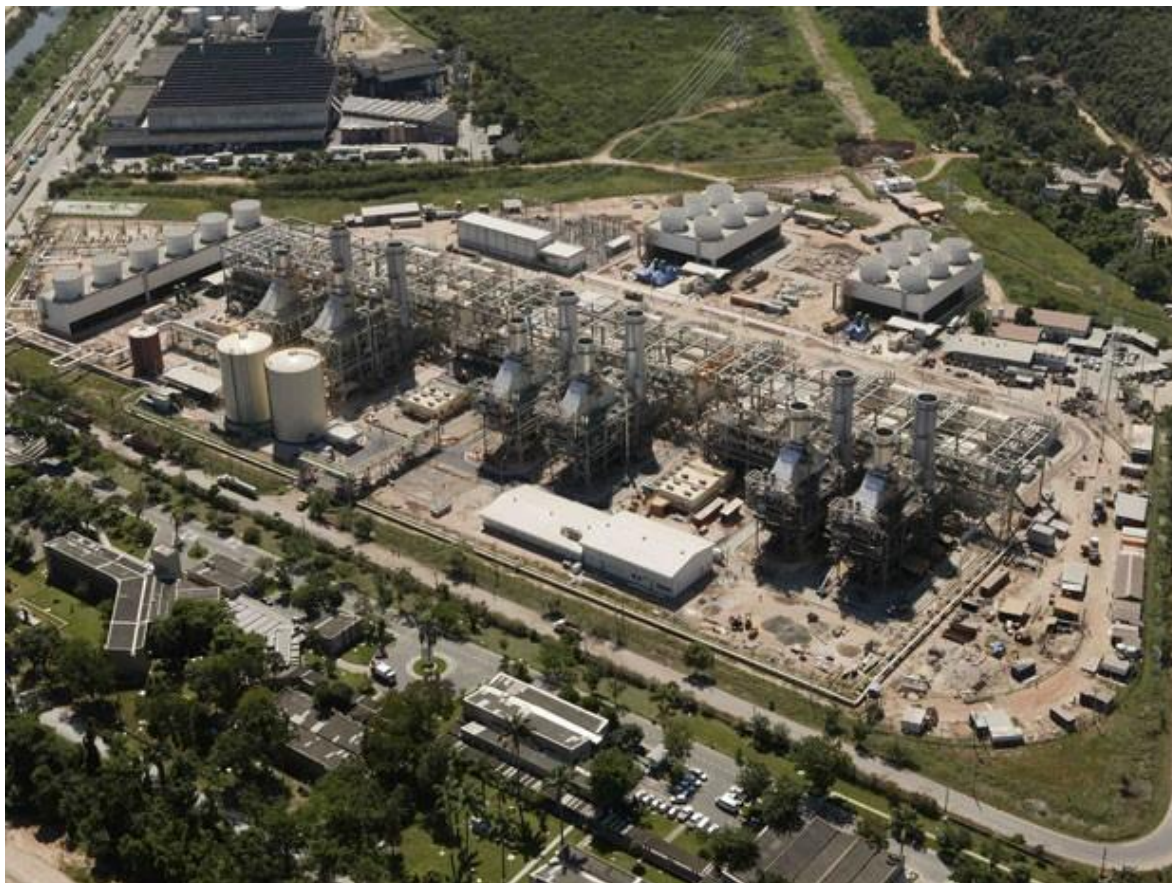
Usina termelétrica da Petrobras em Duque de Caxias (RJ). Lista colocou a estatal brasileira entre as 20 empresas que mais emitiram gases-estufa em 2013 (Foto: Divulgação/Agência Petrobras)
