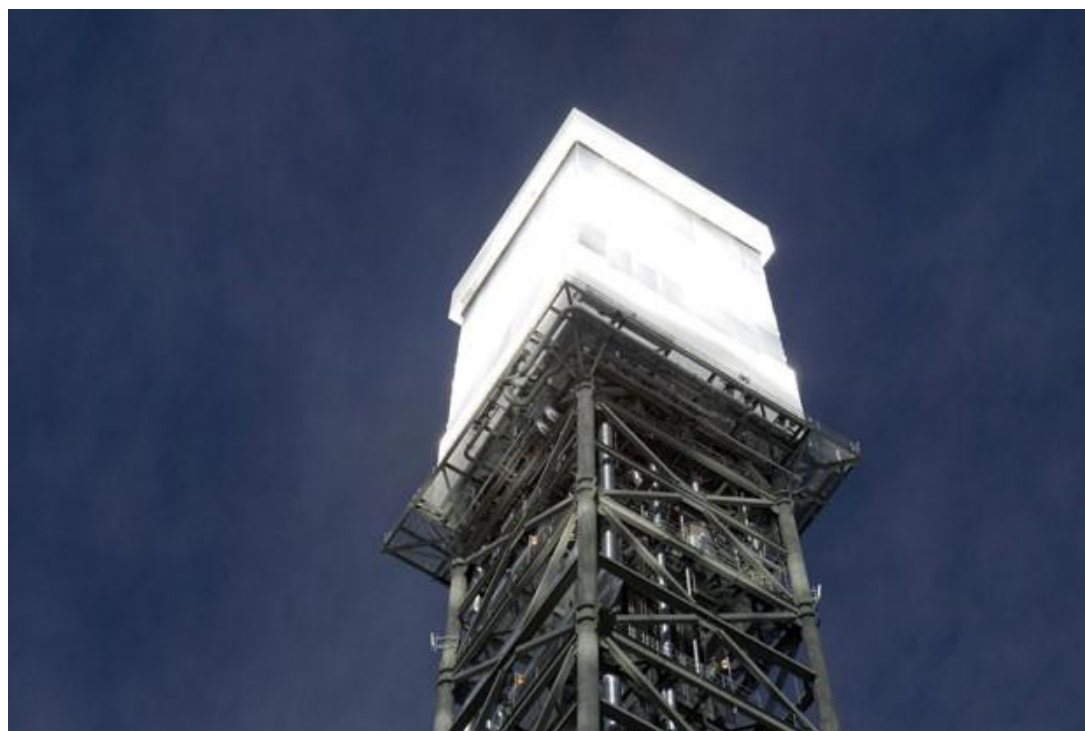
Torres concentram água que é aquecida ao receber a luz solar refletida por painéis solares (Foto: Steve Marcus/Reuters)
